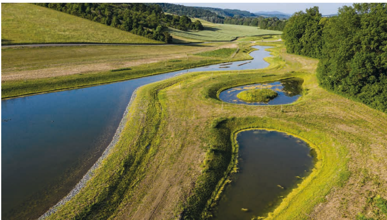
Revitalizační opatření Drslavice – tůň, Ekostavby Brno, a. s., 2020 (zdroj: SPÚ)
