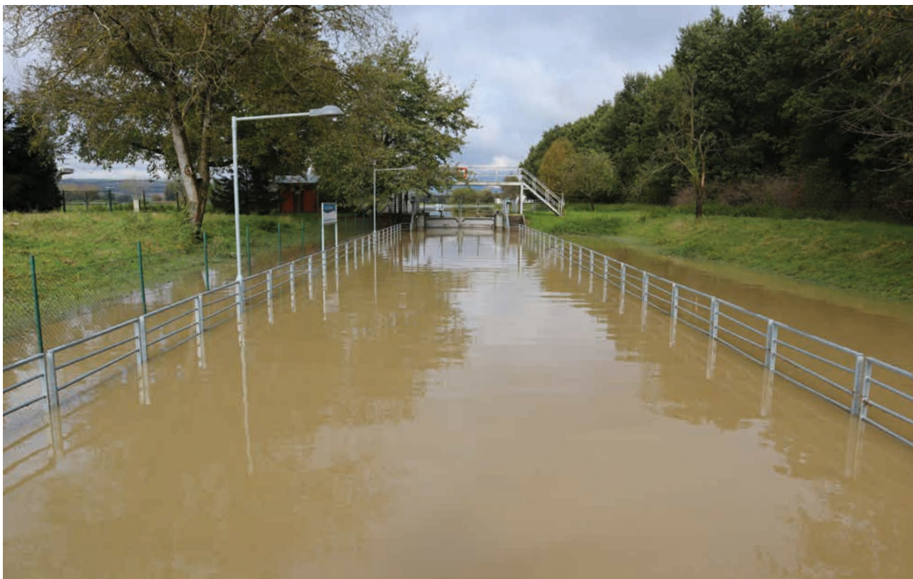
Morava jez Nedakonice, plavební komora (zdroj: Povodí Moravy)
