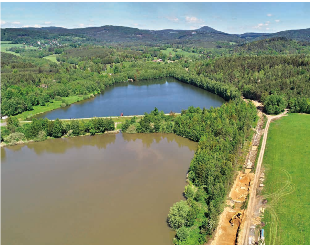
Revitalizace Svitavka (zdroj: Povodí Ohře)
