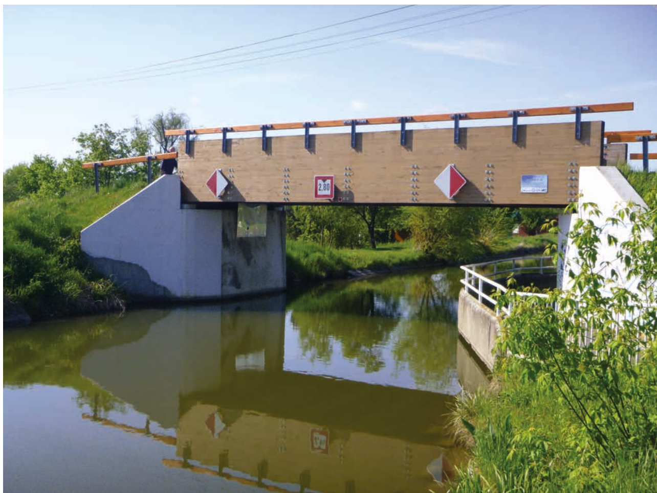
Nově osazené plavební značení na vodní cestě Baťův kanál, Babice (zdroj: Povodí Moravy)
