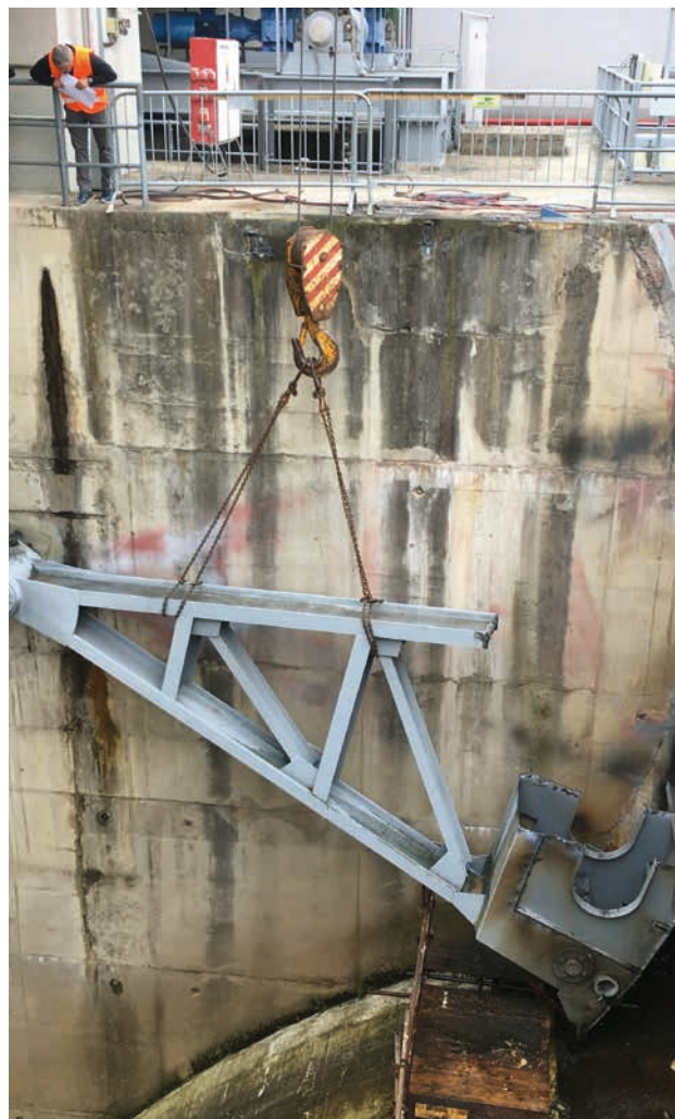
VD Hněvkovice, zabezpečení VD díla před účinky velkých vod (zdroj: Povodí Vltavy)
