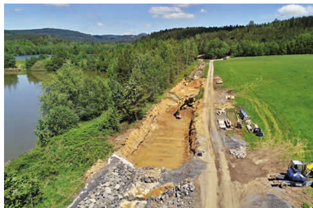
Revitalizace Svitavka (zdroj: Povodí Ohře)
