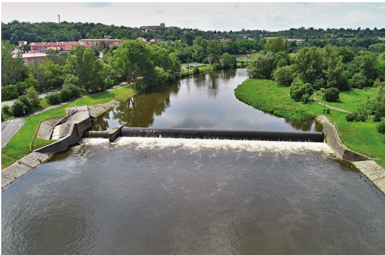
Jez Žatec (zdroj: Povodí Ohře)
