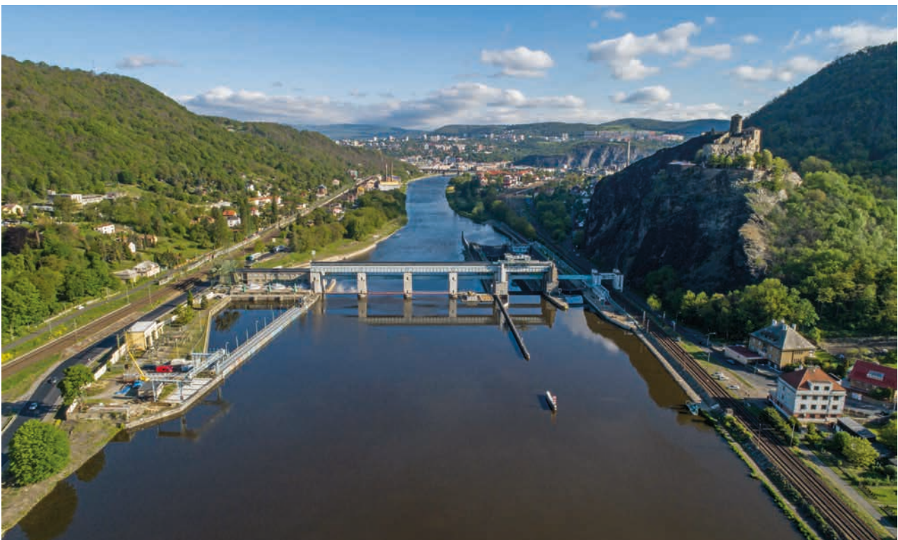
Zdyadlo Střekov (zdroj: Povodí Labe)
