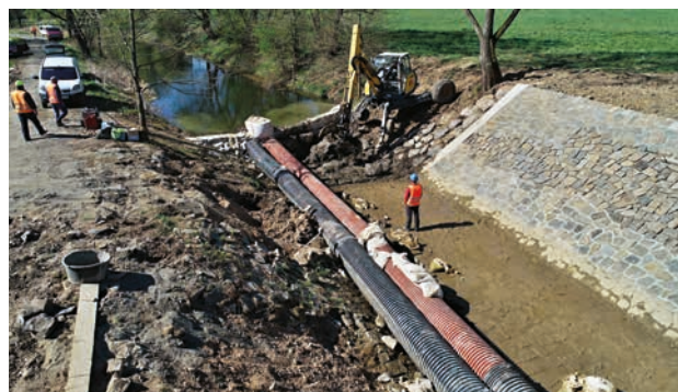
Rekonstrukce limnigrafické stanice Jesenice (zdroj: Povodí Ohře)
