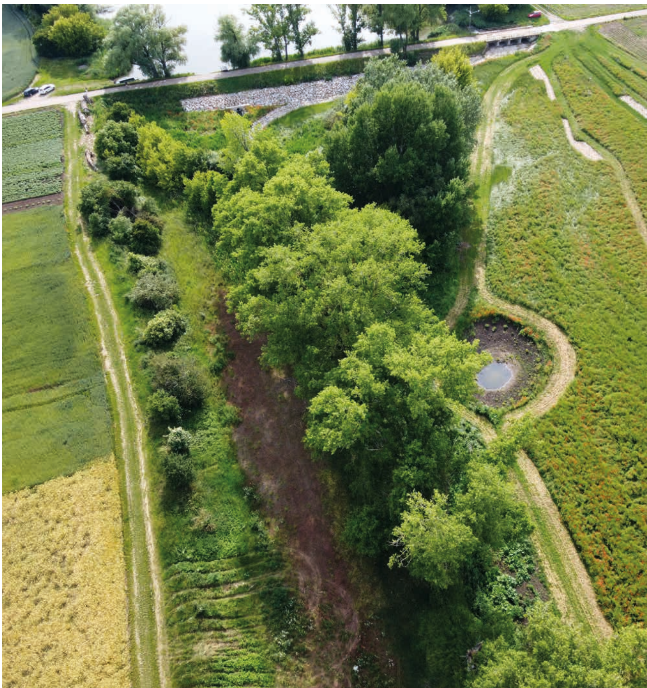
Poldr na Šumickém potoce v k.ú. Pohořelice nad Jihlavou – Opevnění vzdušné paty Pohořelického rybníka a výsadby (zdroj: SPÚ)
