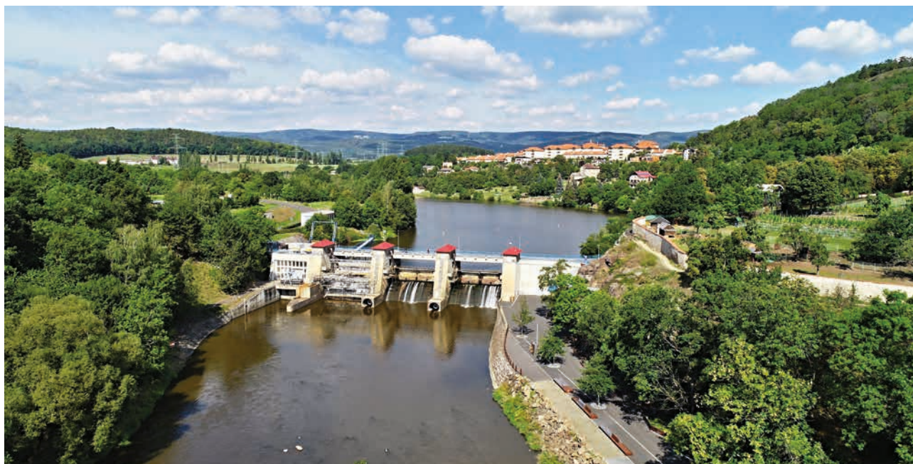
Revitalizace VD Kadaň (zdroj: Povodí Ohře)
