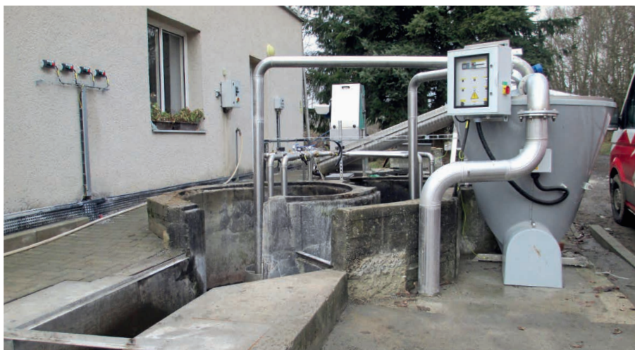
Kasejovice – kanalizace a ČOV – spolufinancováno z dotačních prostředků MZe ve výši 9,830 mil. Kč
