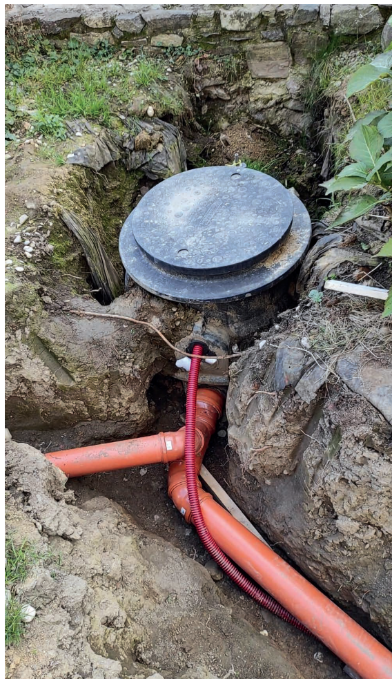
Žďár – dostavba kanalizace – spolufinancováno z dotačních prostředků MZe ve výši 3,313 mil. Kč
