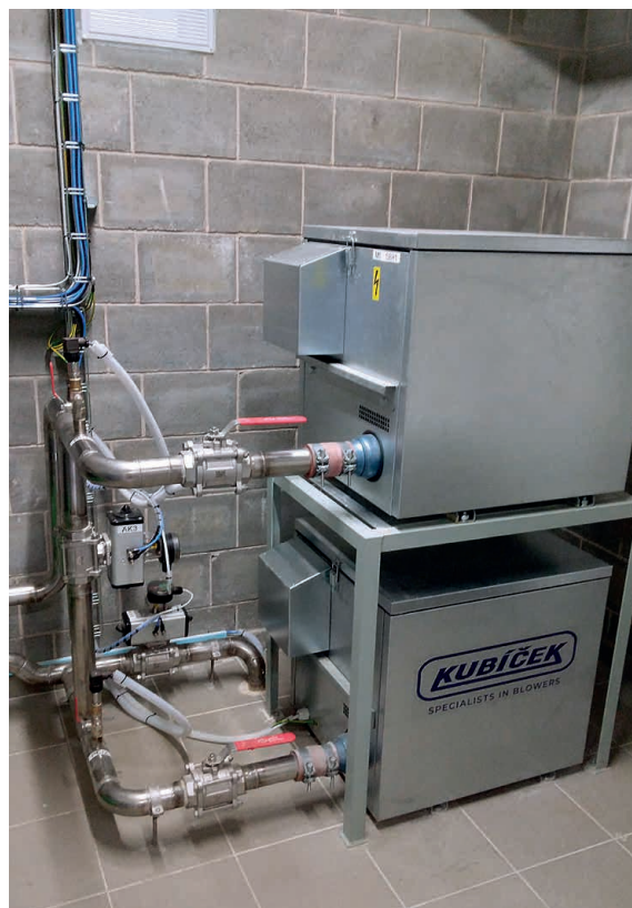
Otročin, Brt' – tlaková kanalizace a ČOV – spolufinancováno z dotačních prostředků MZe ve výši 17,219 mil. Kč
