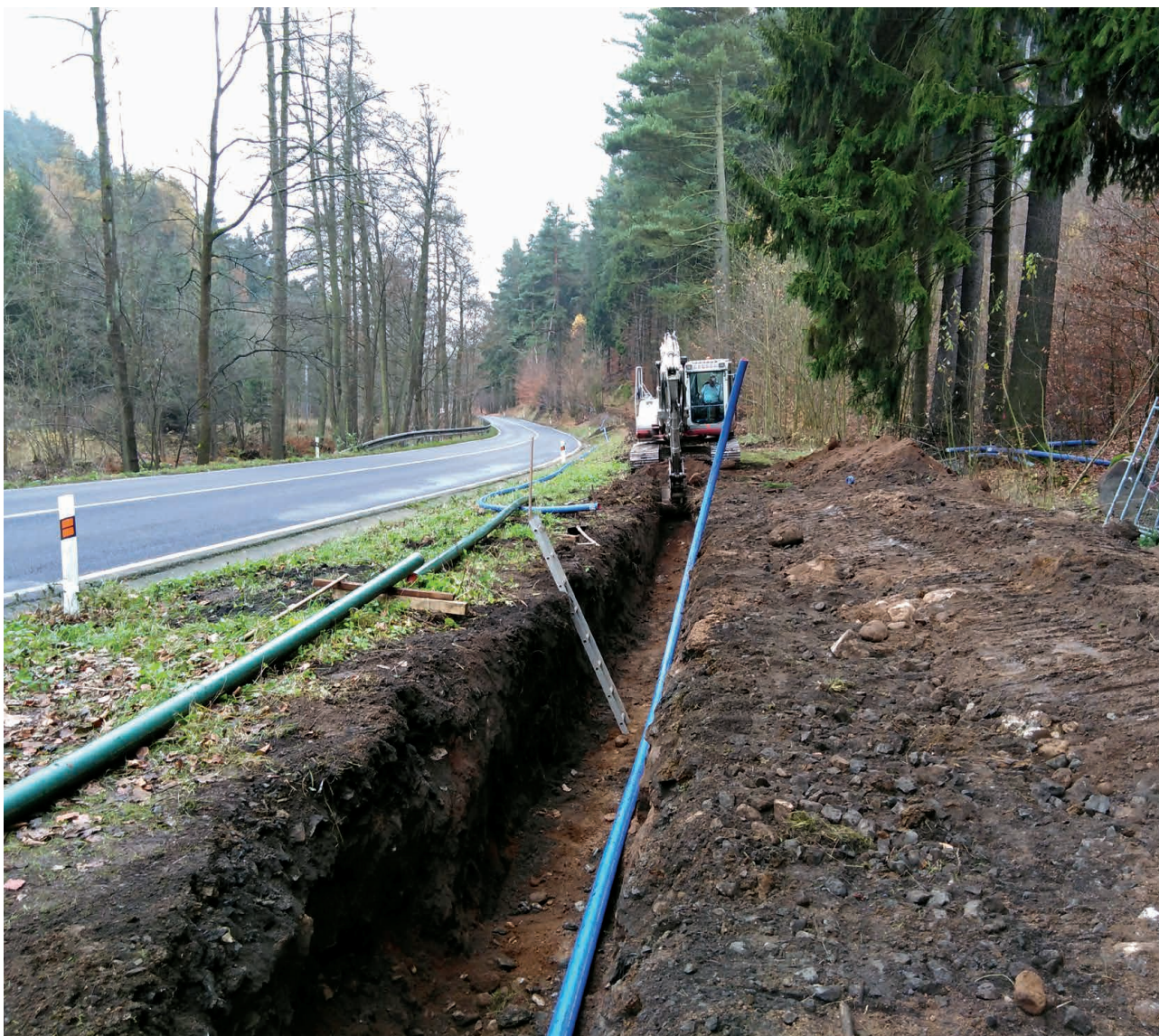
Merklín – napojení Merklína na vodovod a kanalizaci Hroznětín – spolufinancováno z dotačních prostředků MZe ve výši 2,508 mil. Kč
