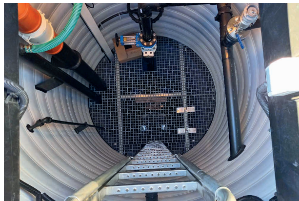
Přestavky – kanalizace – spolufinancováno z dotačních prostředků MZe ve výši 29,489 mil. Kč
