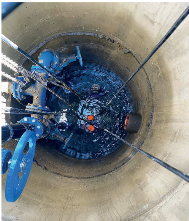
Planá – kanalizace – spolufinancováno z dotačních prostředků MZe ve výši 14,612 mil. Kč
