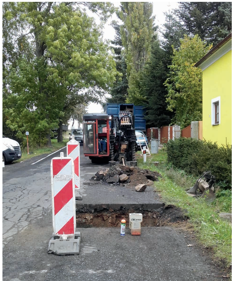
Otročin, Brno – tlaková kanalizace a ČOV – spolufinancováno z dotačních prostředků MZe ve výši 17,219 mil. Kč
