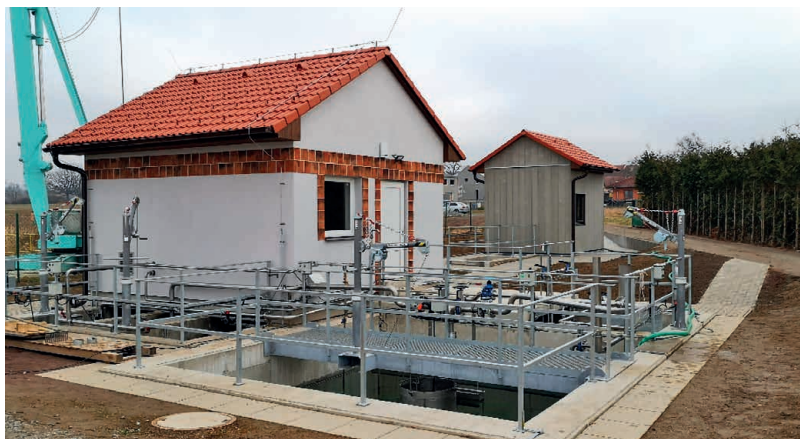
Libnič – čistírna odpadních vod - spolufinancováno z dotačních prostředků MZe ve výši 6,904 mil. Kč
