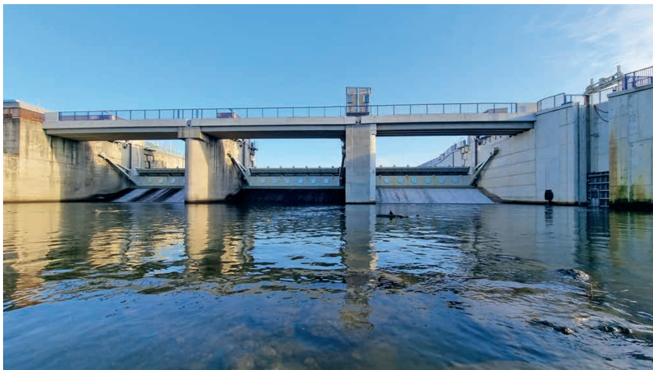
Jez Hranice, po dokončení, leden 2022 (zdroj: Povodí Moravy)
