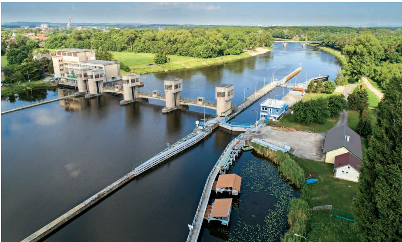
Zdynadlo Kostelec na labské vodní cestě (zdroj: Povodí Labe)
