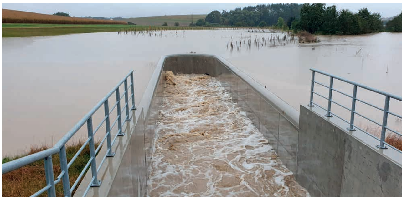
Suchá retenční nádrž v k.ú. Mysločovice při zachycení příválové srážky (zdroj: SPÚ)
