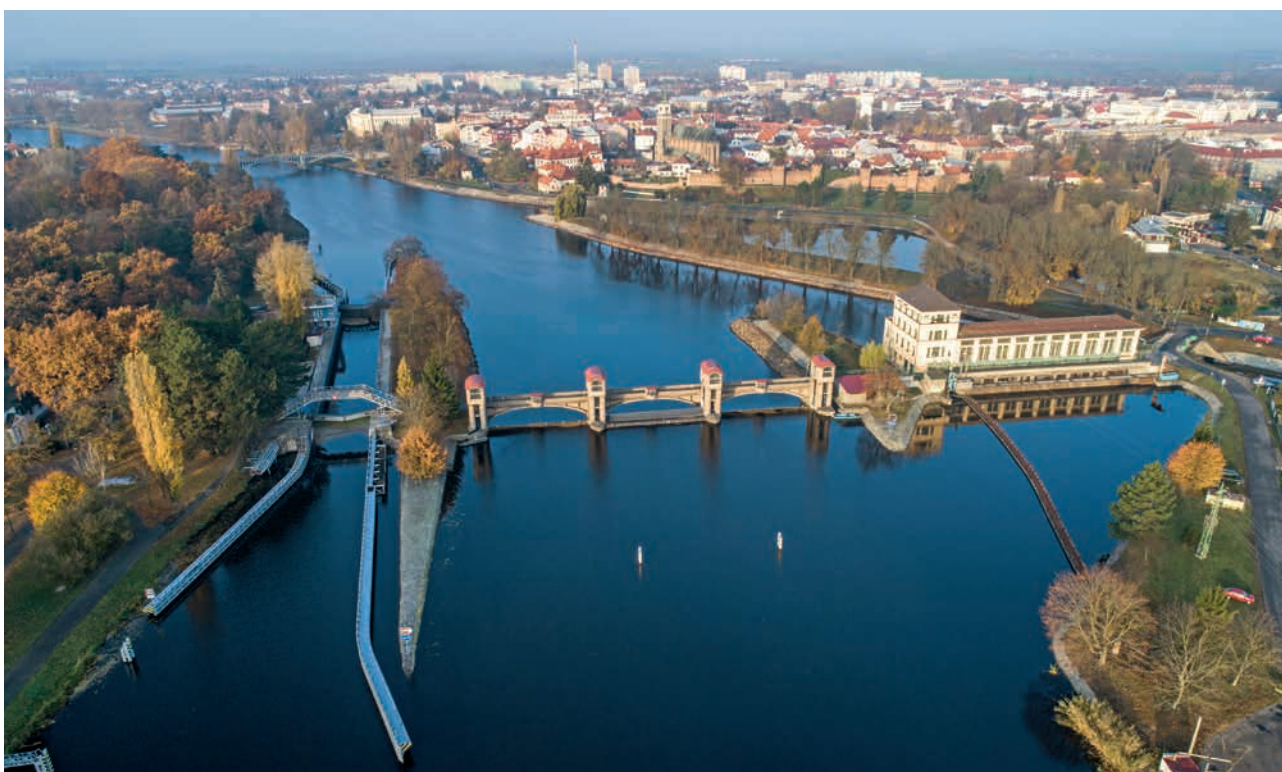
Zdynadlo Nymburk na labské vodní cestě (zdroj: Povodí Labe)
