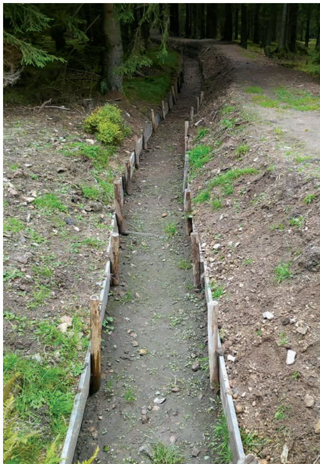
Blatenský příkop, oprava opevnění (autor: Hubalová Petra)
