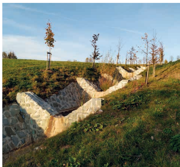
Svodný příkop s retardačními prvky a doprovodnou zelení v k. ú. Třanovice (zdroj: SPÚ)
