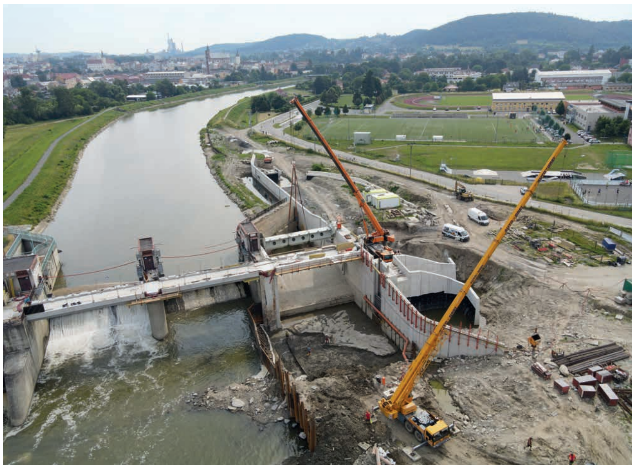
Jez Hranice, průběh stavby, červen 2021 (zdroj: Povodí Moravy)
