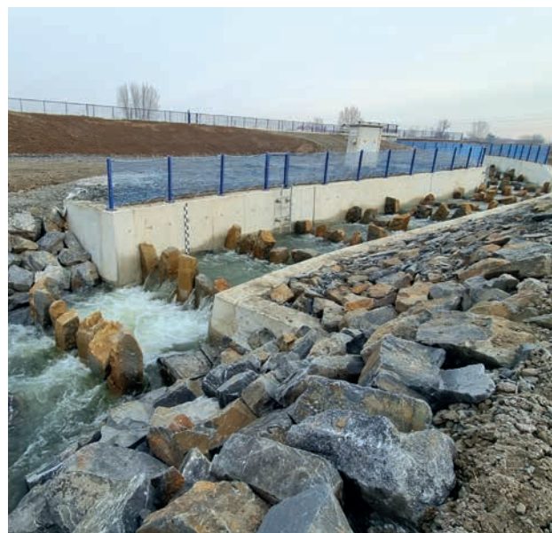
Jez Hranice, nový rybí přechod, leden 2022 (zdroj: Povodí Moravy)
