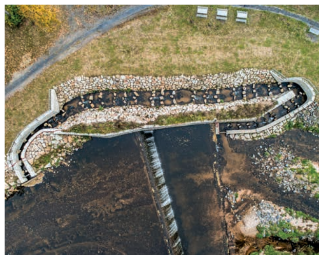
Rybí přechod na Smědě ve Frýdlantu (zdroj: Povodí Labe)
