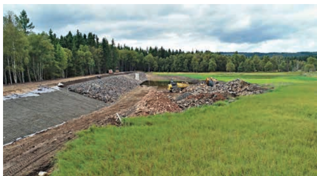
Starý rybník, stavba (zdroj: Povodí Ohře)
