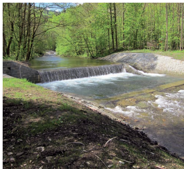
Spádový stupeň na řece Mohelnici (zdroj: Povodí Odry)
