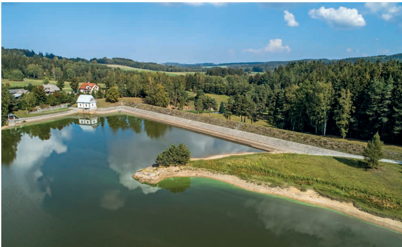
Vodárenská nádrž Hamry (zdroj: Povodí Labe)
