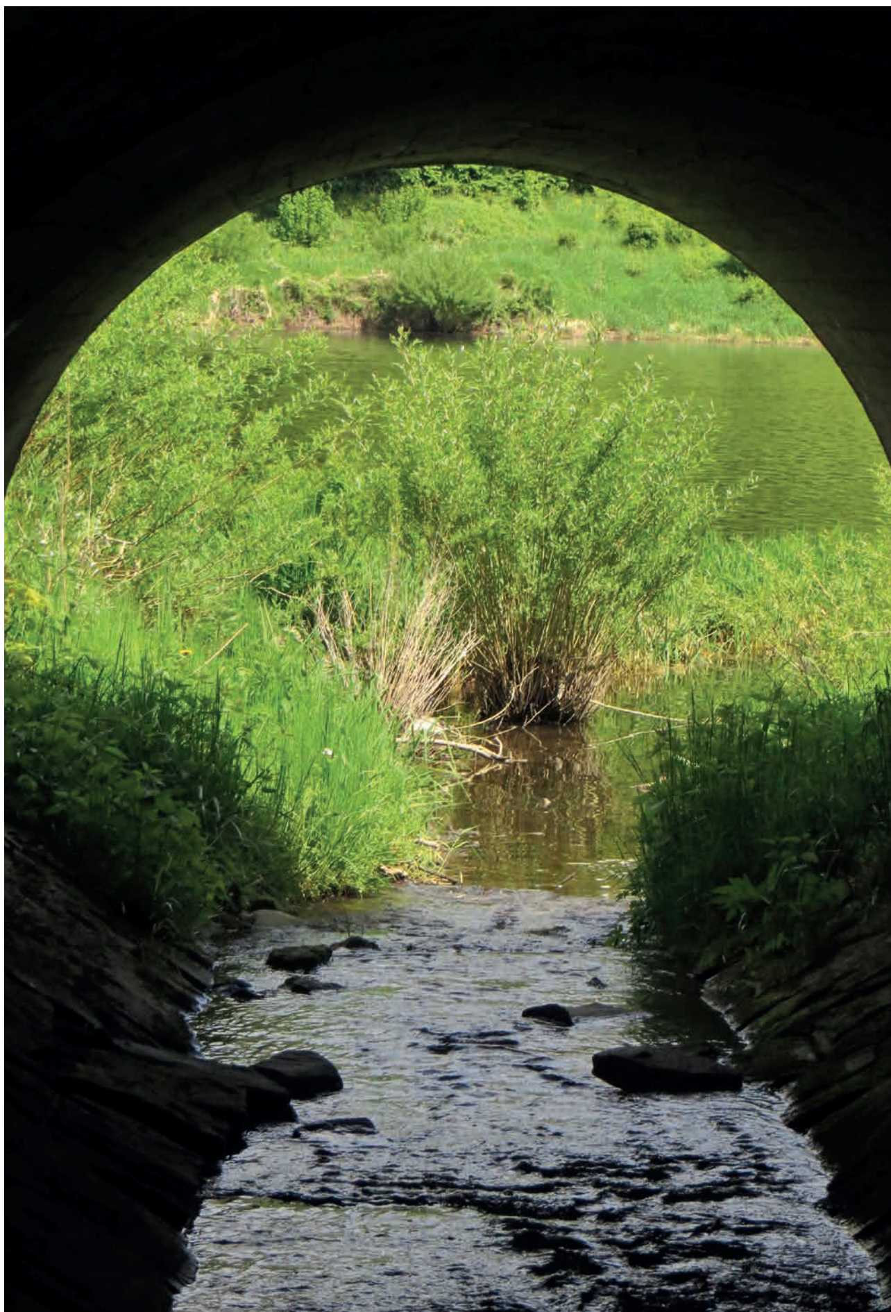
Tunel pro vodu, červen 2021, Karasínský potok, VN Vír (autor: Lošťáková Zuzana)
