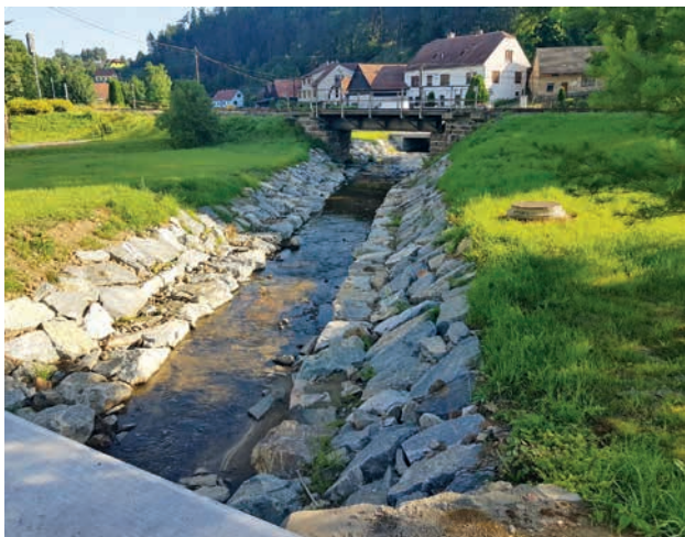
Zkapacitnění toku Rožinka v intravilánu obce Rožná na Žďarsku (zdroj: LČR)
