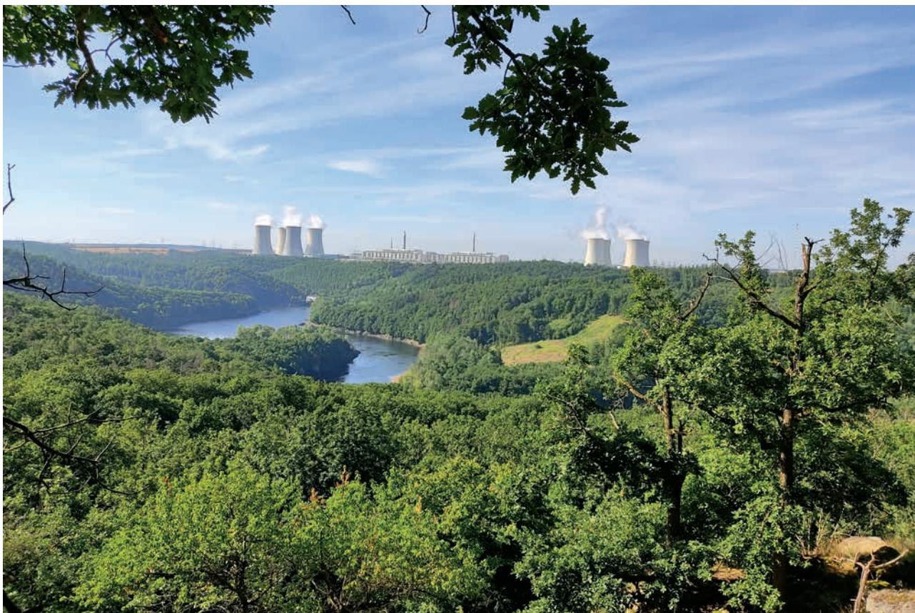
Čerpací stanice chladicí vody k jaderné elektrárně Dukovany, červenec 2021, VN Mohelno (autor: Pavlíková Eliška)
