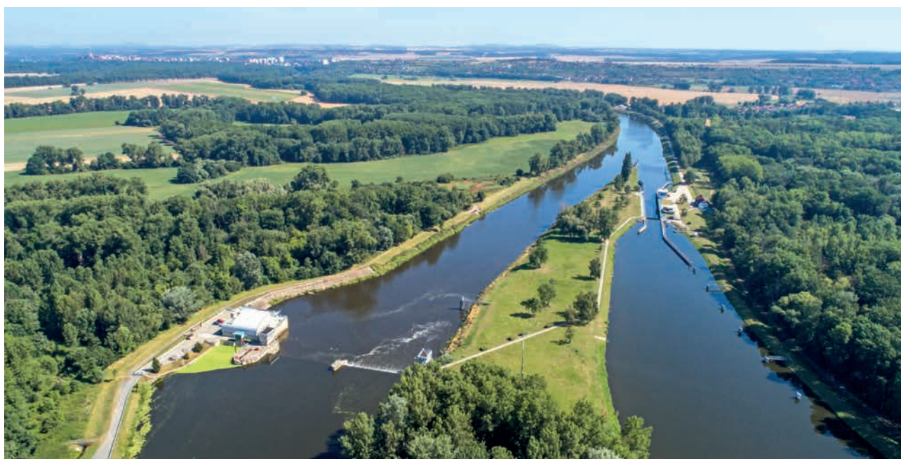
Zdymadlo Obříství na labské vodní cestě (zdroj: Povodí Labe)
