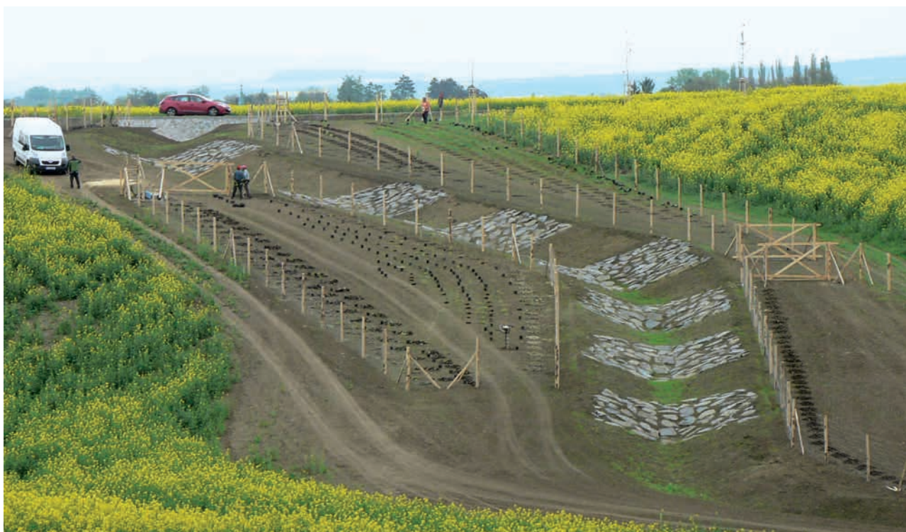
Stavba protierozního a protipovodňového opatření v k. ú. Hruška (zdroj: SPÚ)
