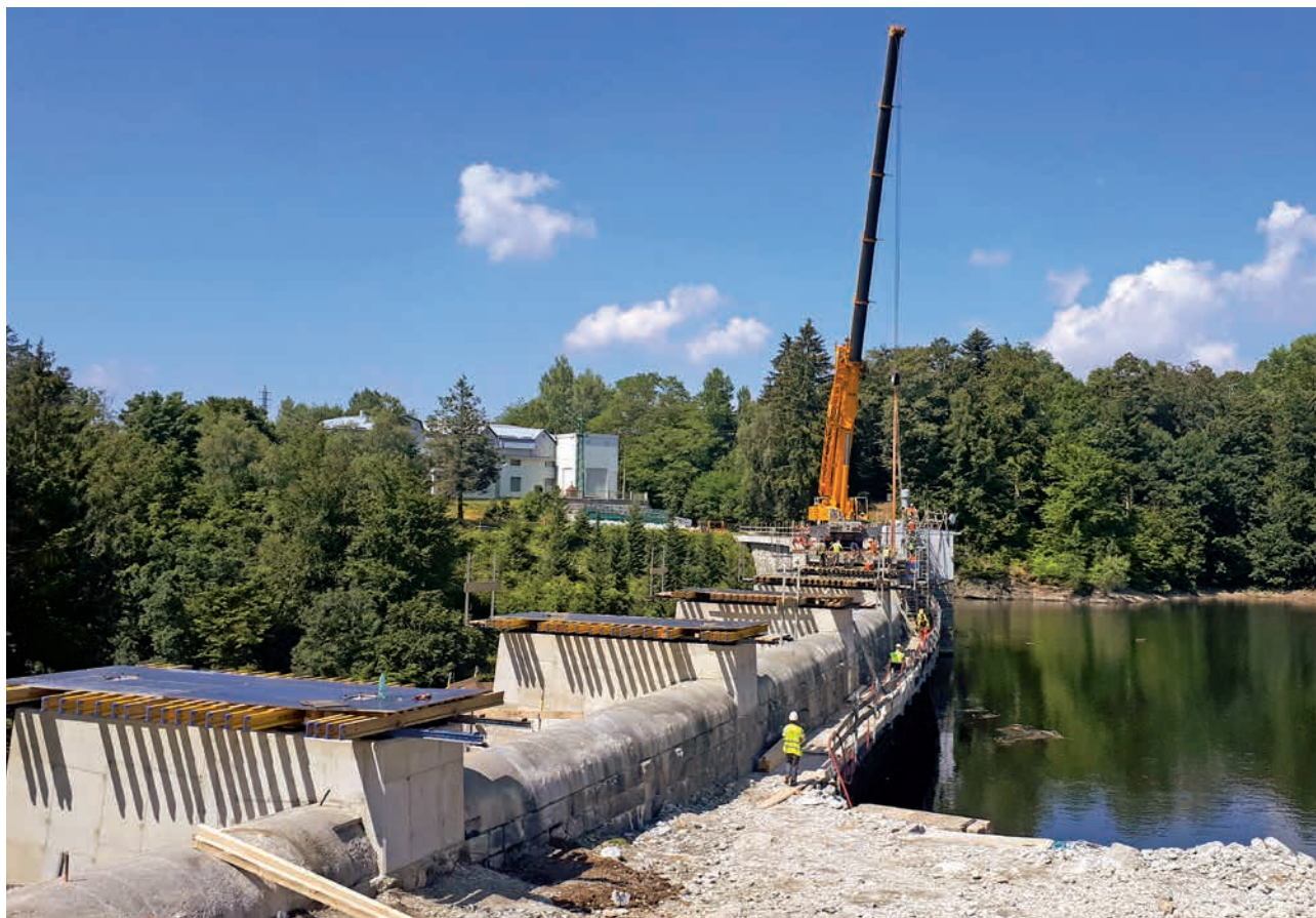
Rekonstrukce koruny hráze, VD Pastviny (zdroj: Povodí Labe)
