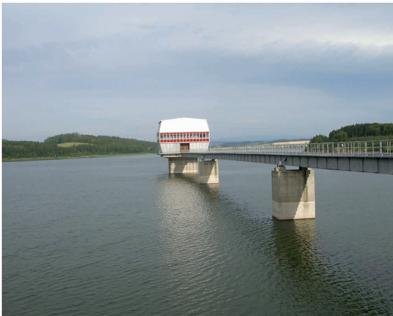
Vodní nádrž Slezská Harta – odběrná věž (zdroj: Povodí Odry)
